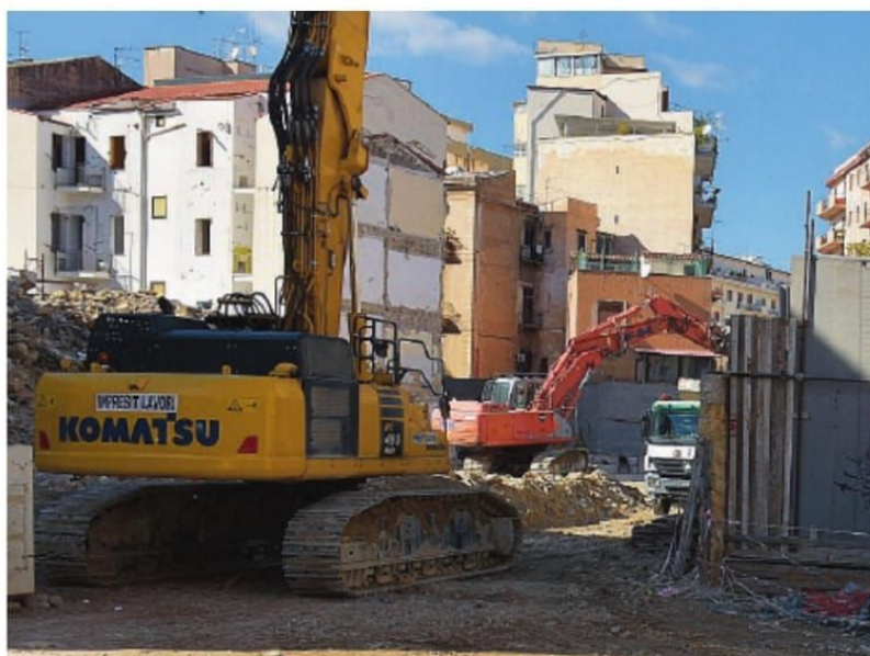
Vicolo Bernava. I lavori del passante ferroviario vanno avanti
