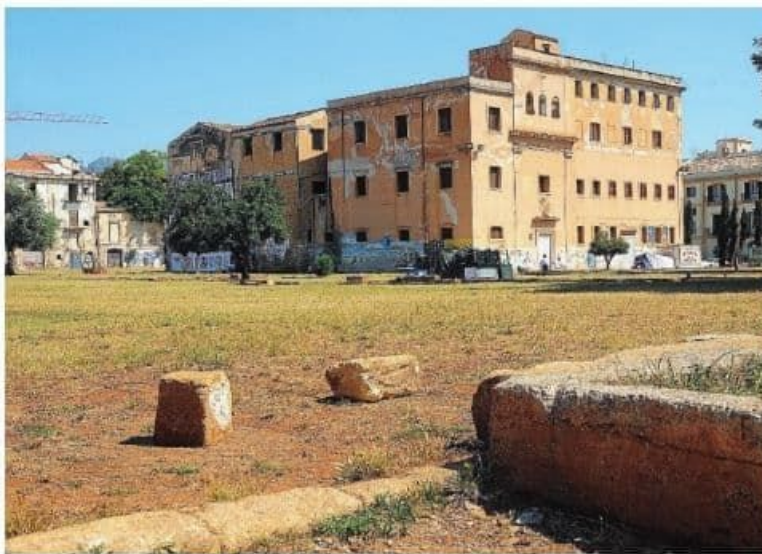
Piazza Magione. La grande area sarà oggetto di uno dei 34 interventi di riqualificazione
