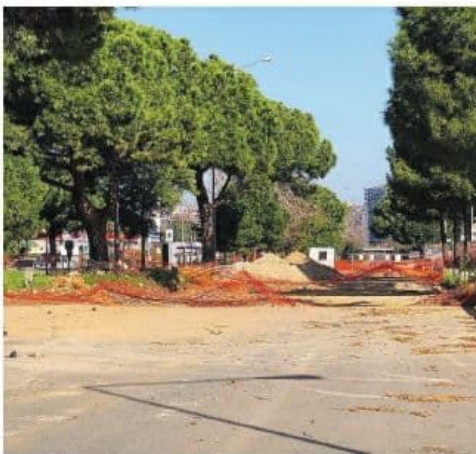
Tratto chiuso. Il cantiere per la copertura del canale Mortillaro
