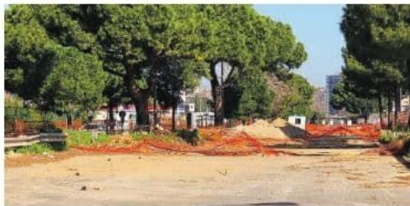
Viale Regione. Il cantiere per la copertura del canale Mortillaro
